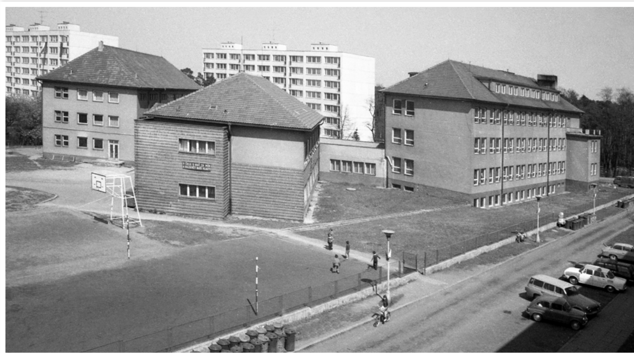
Přístavba základní školy. Sbírka fotografií Základní školy Vítězslava Jeálka Odolena Voda.
